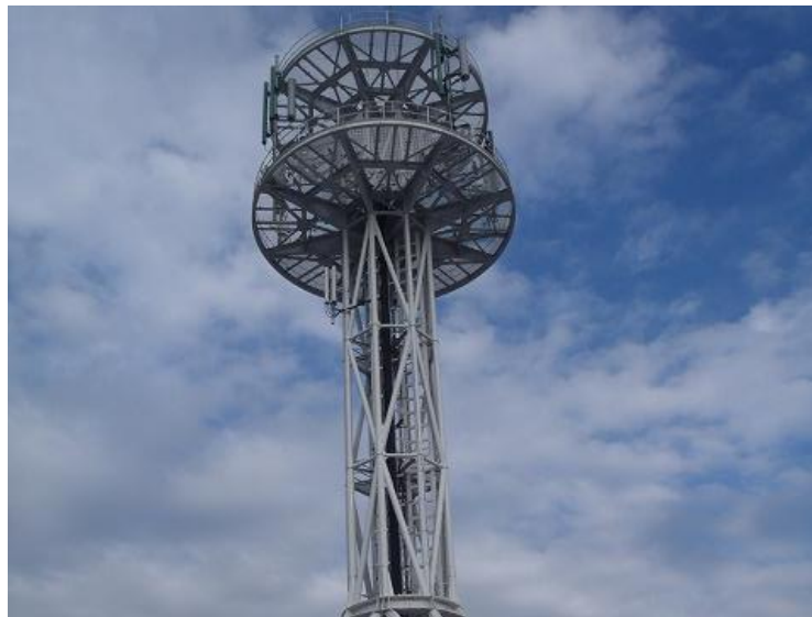
* 通信事業者等からの鉄塔の譲渡
